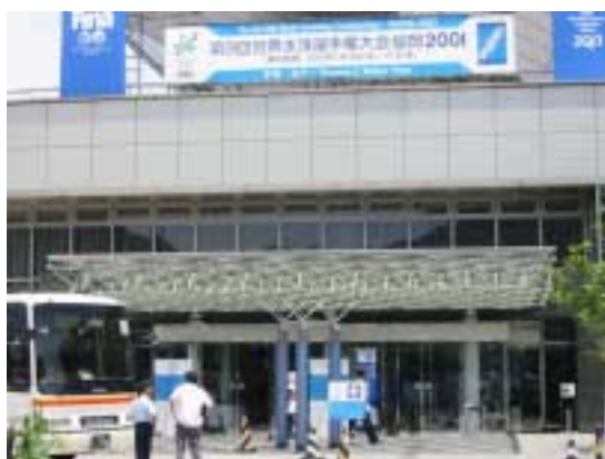
図 35 福岡市立総合西市民プール
