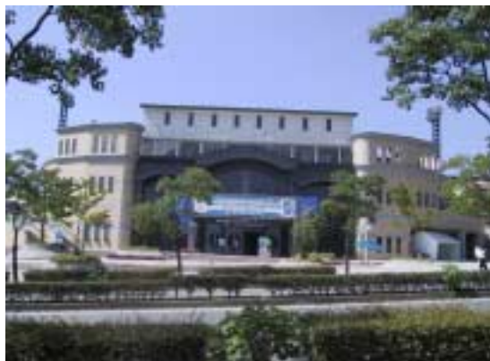
図 7 博多の森センターコート全景
